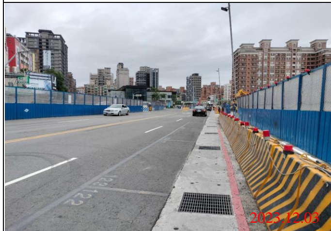
巡查日期地點：112.12.03/ Y22車站 照片說明：路面狀況
