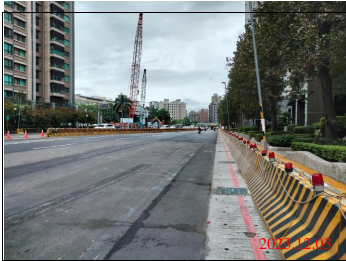
巡查日期地點：112.12.03/ Y23車站 照片說明：路面狀況
