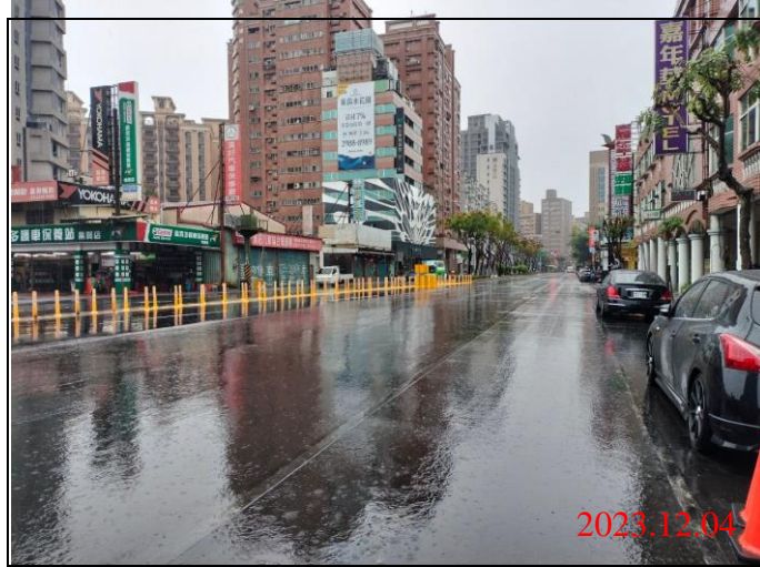
巡查日期地點：112.12.04/ Y21車站 照片說明：路面狀況
