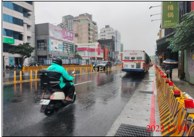
巡查日期地點：112.12.04/ Y21車站 照片說明：路面狀況
