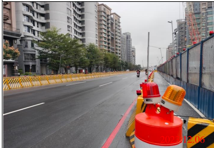
巡查日期地點：112.12.06/ Y23車站 照片說明：路面狀況
