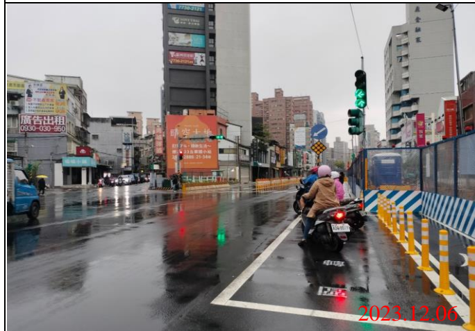
巡查日期地點：112.12.06/ Y21車站 照片說明：路面狀況
