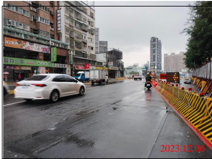
巡查日期地點：112.12.06/ Y22車站 照片說明：路面狀況
