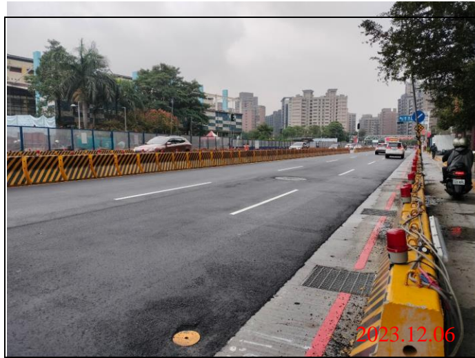
巡查日期地點：112.12.06/ Y23車站 照片說明：路面狀況
