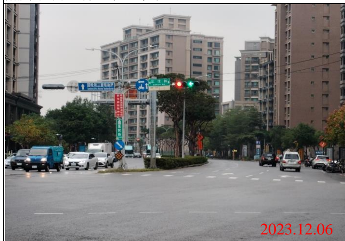
巡查日期地點：112.12.06/ Y23車站 照片說明：牌面設置狀況
