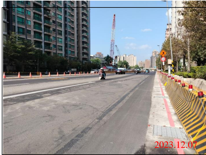
巡查日期地點：112.12.07/ Y23車站 照片說明：路面狀況
