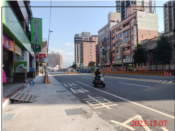
巡查日期地點：112.12.07/ Y22車站 照片說明：路面狀況
