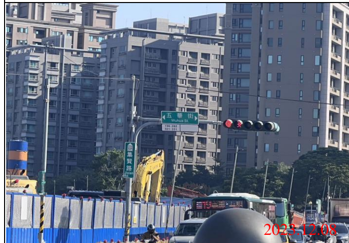
巡查日期地點：112.12.08/ Y22車站 照片說明：牌面設置狀況
