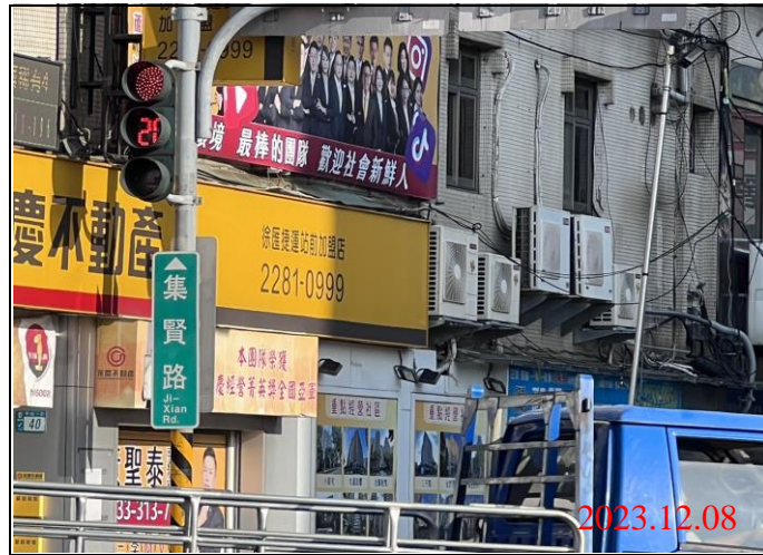
巡查日期地點：112.12.08/ Y21車站 照片說明：牌面設置狀況
