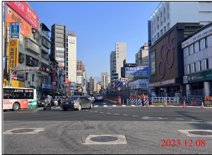
巡查日期地點：112.12.08/ Y21車站 照片說明：路面狀況
