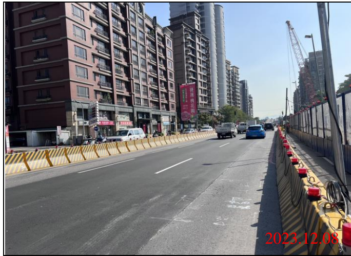
巡查日期地點：112.12.08/ Y23車站 照片說明：路面狀況
