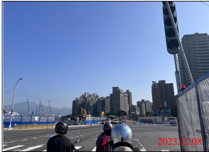
巡查日期地點：112.12.08/ Y22車站 照片說明：路面狀況
