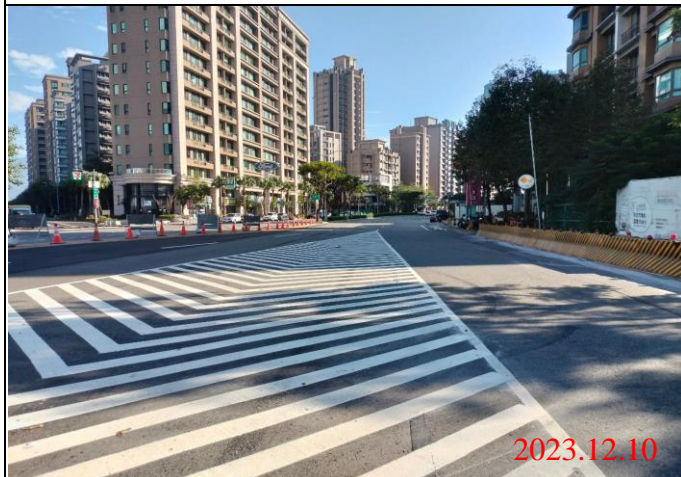
巡查日期地點：112.12.10/ Y22車站 照片說明：路面狀況
