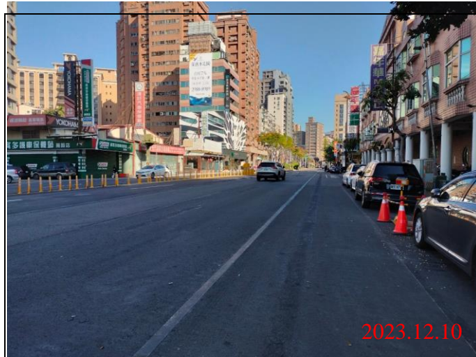
巡查日期地點：112.12.10/ Y21車站 照片說明：路面狀況
