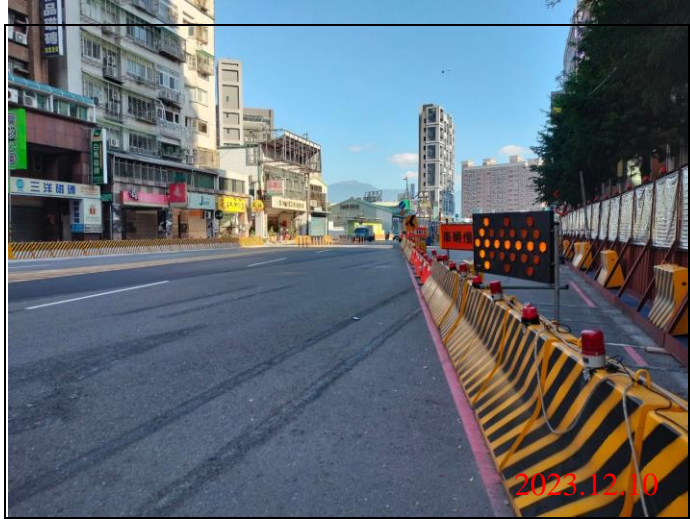
巡查日期地點：112.12.10/ Y22車站 照片說明：路面狀況
