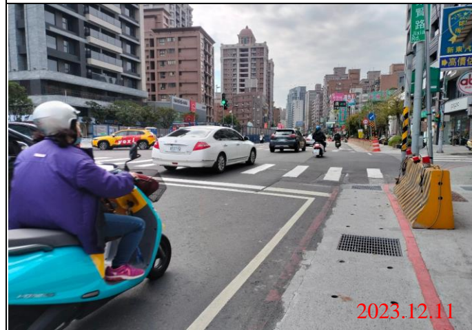
巡查日期地點：112.12.11/ Y22車站 照片說明：路面狀況
