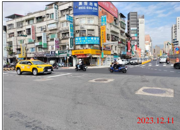
巡查日期地點：112.12.11/ Y21車站 照片說明：路面狀況
