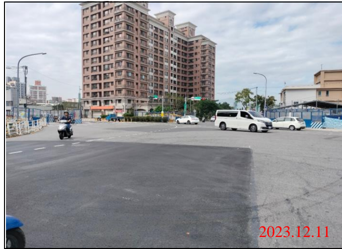
巡查日期地點：112.12.11/ Y22車站 照片說明：路面狀況
