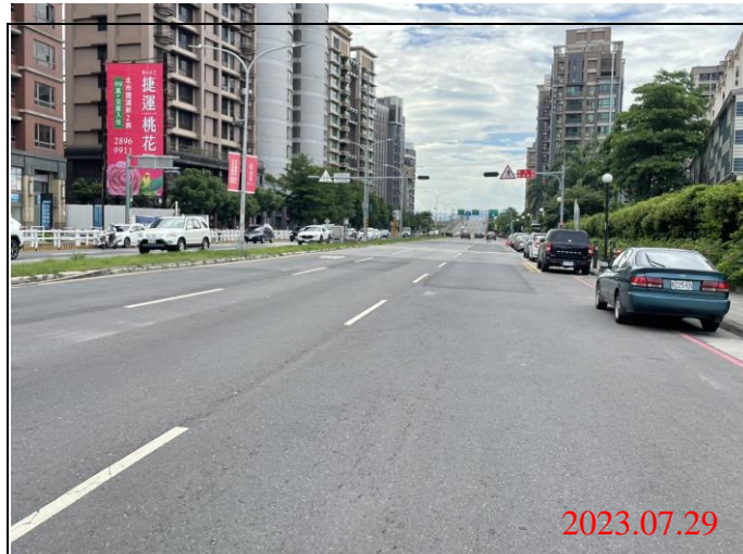
巡查日期地點：112.07.29/ Y23車站 照片說明：路面狀況
