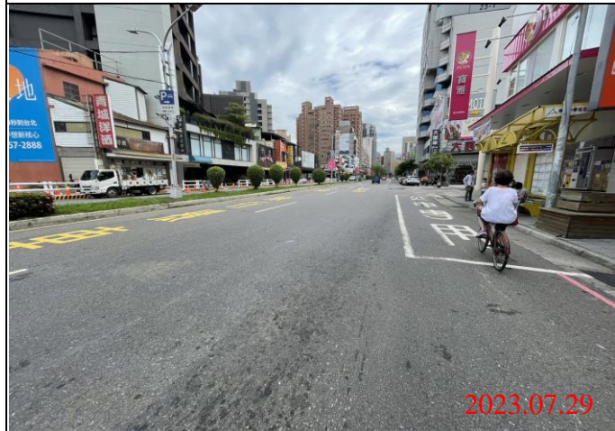
巡查日期地點：112.07.29/ Y21車站 照片說明：路面狀況
