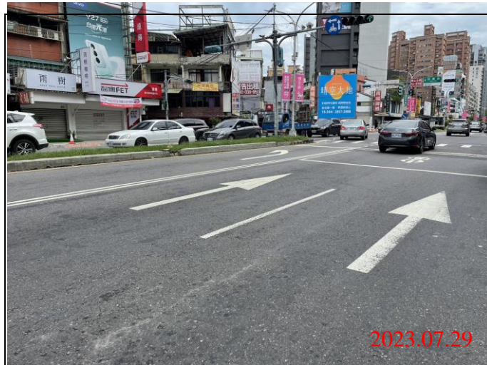
巡查日期地點：112.07.29/ Y21車站 照片說明：路面狀況
