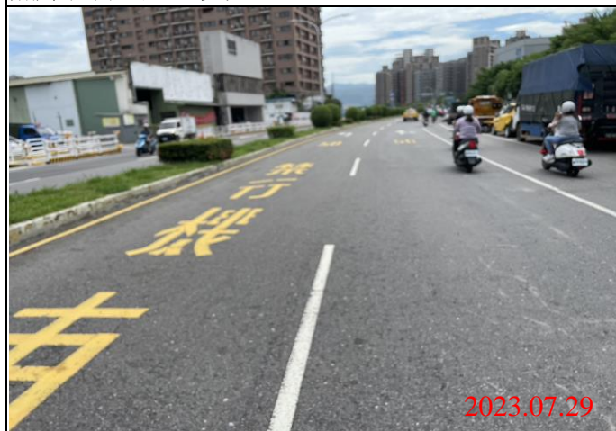
巡查日期地點：112.07.29/ Y22車站 照片說明：路面狀況
