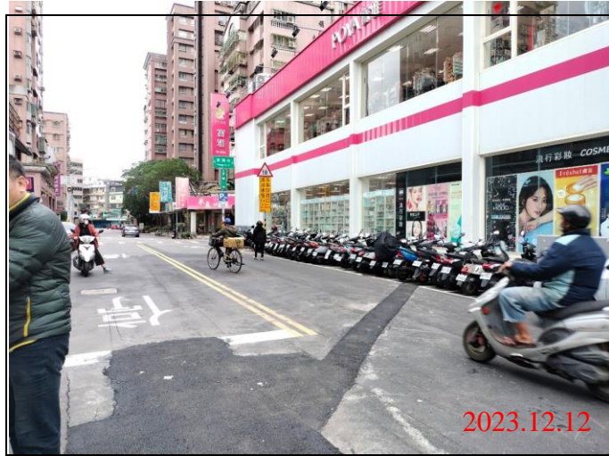
巡查日期地點：112.12.12/ Y21車站 照片說明：路面狀況
