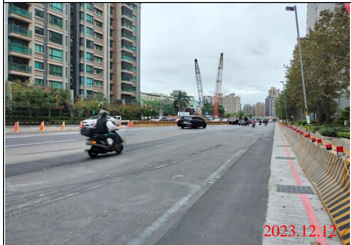
巡查日期地點：112.12.12/ Y23車站 照片說明：路面狀況
