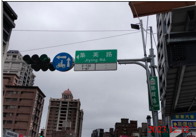
巡查日期地點：112.12.12/ Y22車站 照片說明：牌面設置狀況
