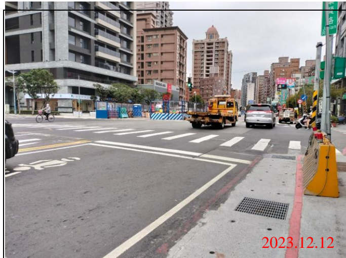
巡查日期地點：112.12.12/ Y22車站 照片說明：路面狀況
