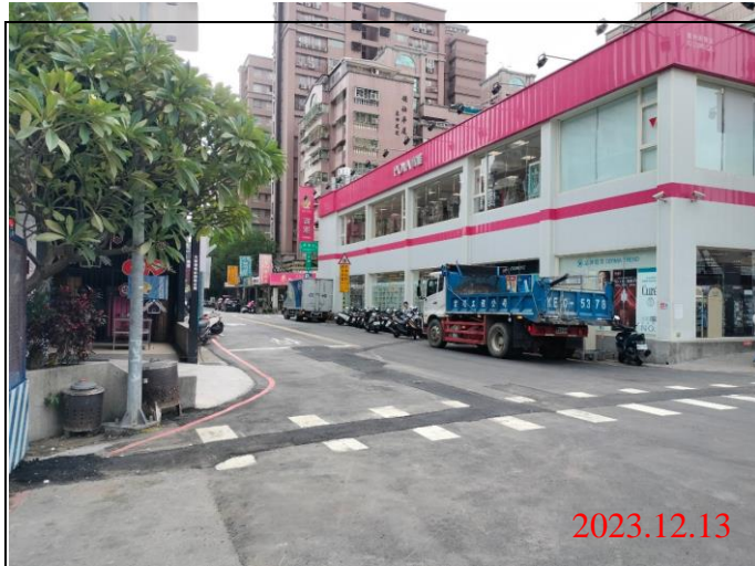
巡查日期地點：112.12.13/ Y21車站 照片說明：路面狀況
