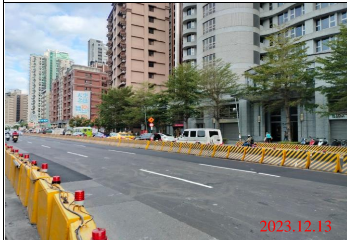
巡查日期地點：112.12.13/ Y23車站 照片說明：路面狀況
