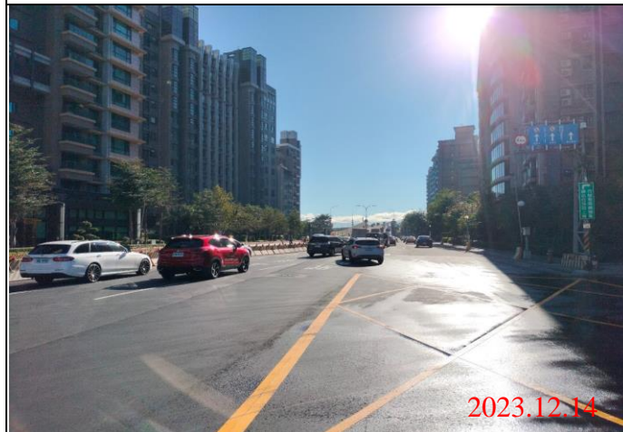
巡查日期地點：112.12.14/ Y23車站 照片說明：路面狀況
