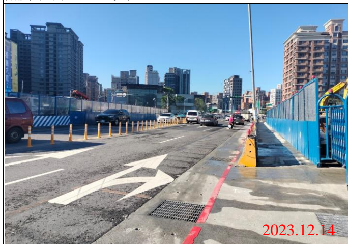
巡查日期地點：112.12.14/ Y22車站 照片說明：路面狀況
