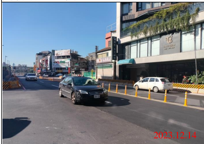
巡查日期地點：112.12.14/ Y21車站 照片說明：路面狀況
