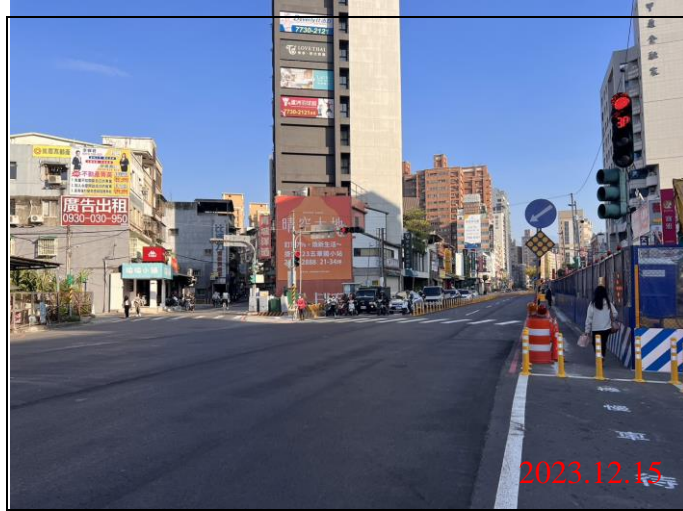
巡查日期地點：112.12.15/ Y21車站 照片說明：路面狀況
