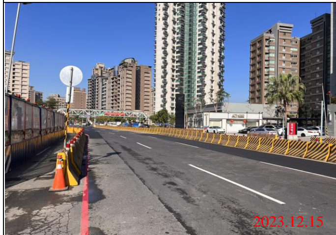
巡查日期地點：112.12.15/ Y23車站 照片說明：路面狀況
