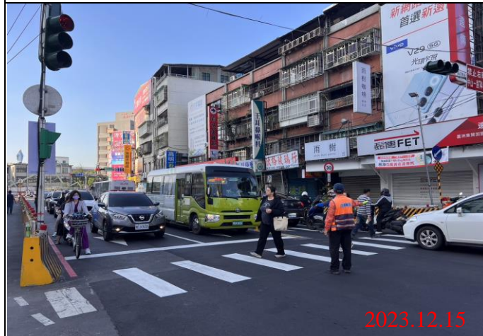
巡查日期地點：112.12.15/ Y21車站 照片說明：路面狀況
