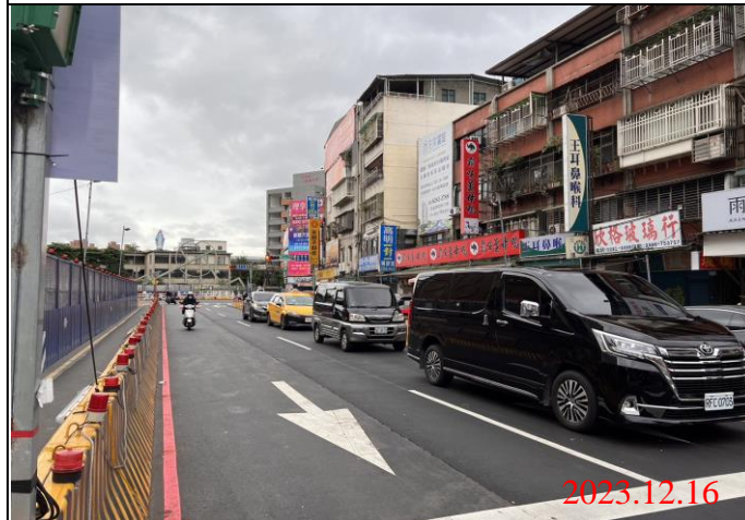
巡查日期地點：112.12.16/ Y21車站 照片說明：路面狀況
