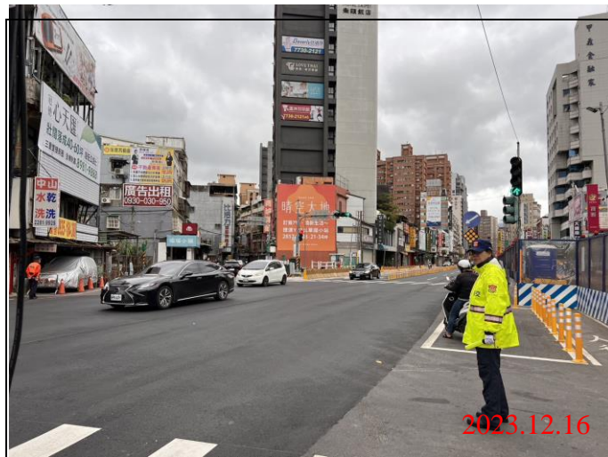
巡查日期地點：112.12.16/ Y21車站 照片說明：路面狀況
