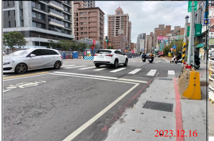
巡查日期地點：112.12.16/ Y22車站 照片說明：路面狀況
