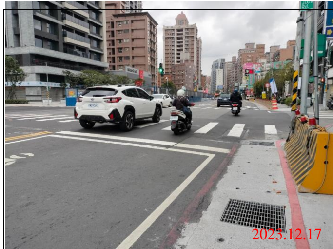
巡查日期地點：112.12.17/ Y22車站 照片說明：路面狀況
