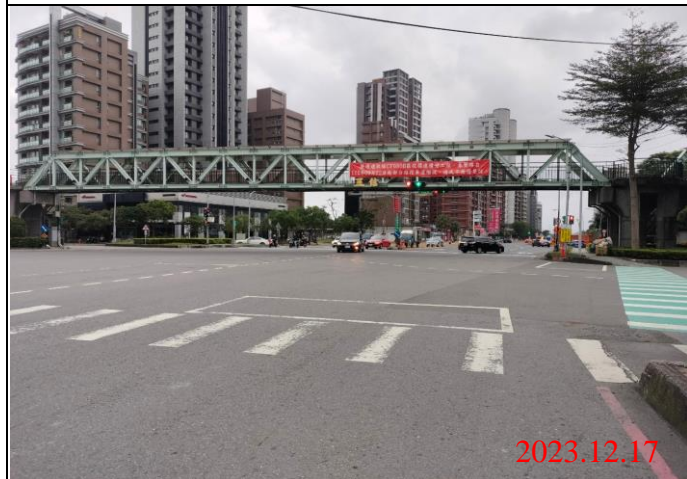
巡查日期地點：112.12.17/ Y23車站 照片說明：路面狀況
