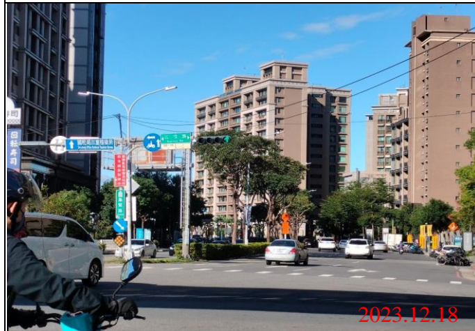
巡查日期地點：112.12.18/ Y23車站 照片說明：牌面設置狀況
