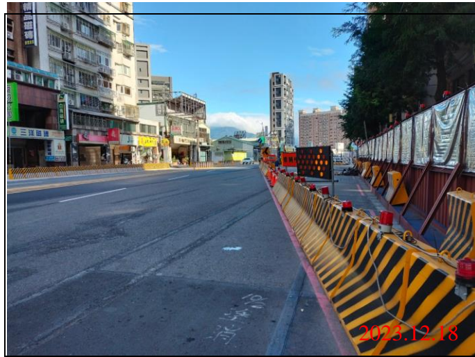
巡查日期地點：112.12.18/ Y22車站 照片說明：路面狀況
