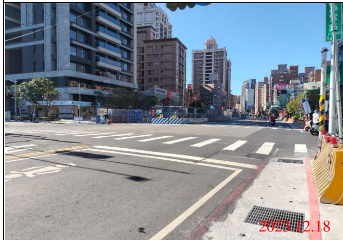
巡查日期地點：112.12.18/ Y22車站 照片說明：路面狀況
