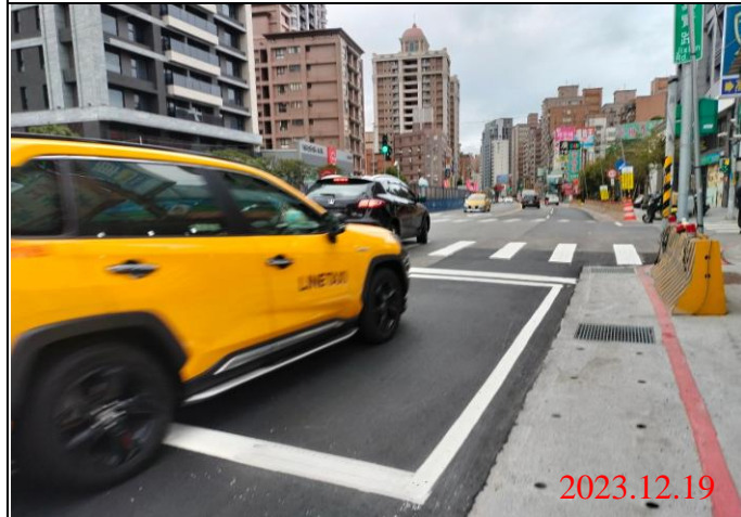
巡查日期地點：112.12.19/ Y22車站 照片說明：路面狀況
