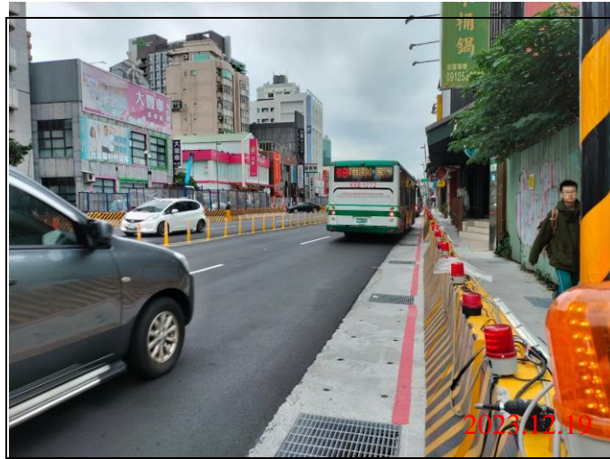
巡查日期地點：112.12.19/ Y21車站 照片說明：路面狀況
