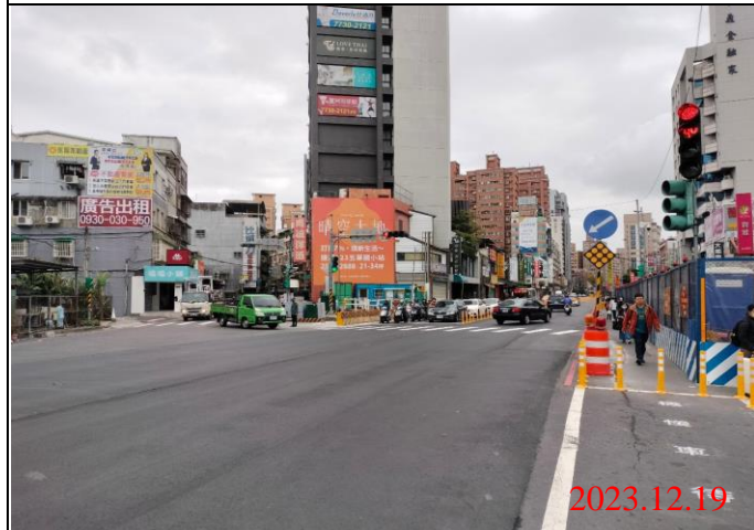
巡查日期地點：112.12.19/ Y21車站 照片說明：路面狀況
