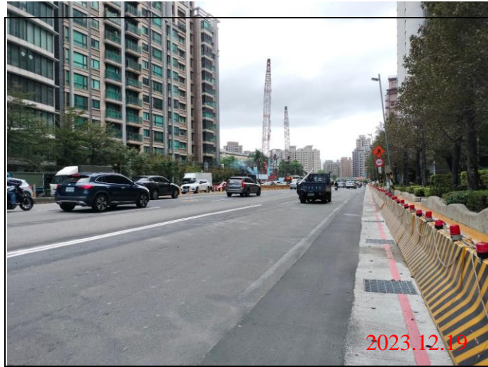
巡查日期地點：112.12.19/ Y23車站 照片說明：路面狀況
