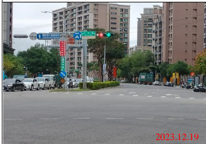
巡查日期地點：112.12.19/ Y23車站 照片說明：牌面設置狀況
