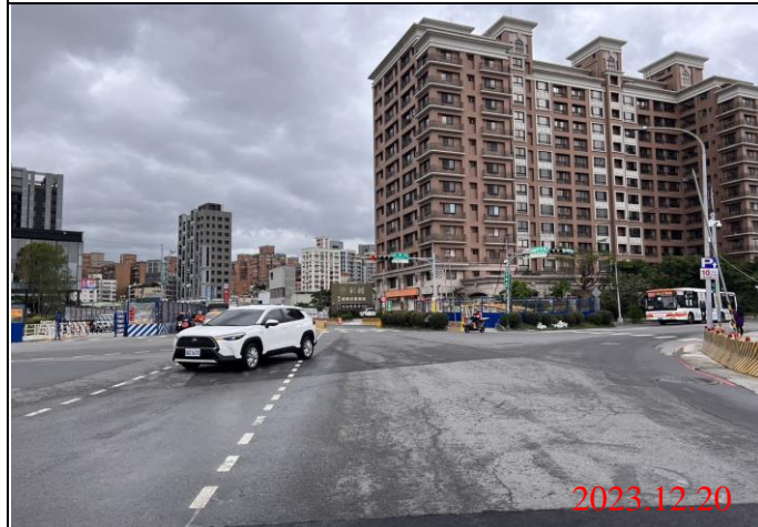
巡查日期地點：112.12.20/ Y22車站 照片說明：路面狀況
