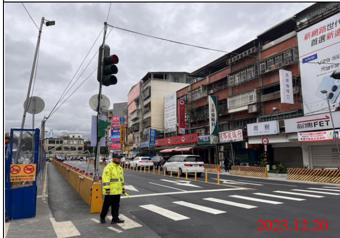
巡查日期地點：112.12.20/ Y21車站 照片說明：路面狀況
