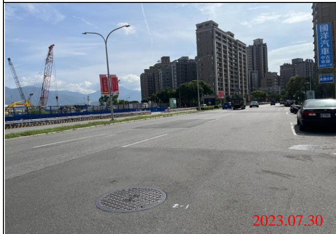
巡查日期地點：112.07.30/ Y22車站 照片說明：路面狀況
