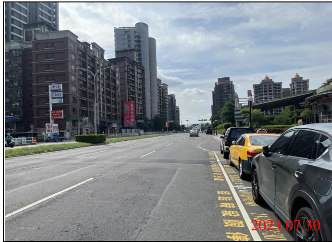
巡查日期地點：112.07.30/ Y23車站 照片說明：路面狀況
