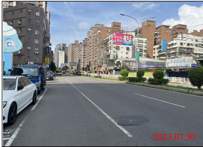
巡查日期地點：112.07.30/ Y22車站 照片說明：路面狀況
