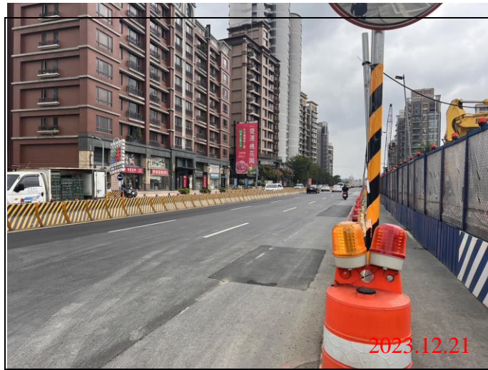
巡查日期地點：112.12.21/ Y23車站 照片說明：路面狀況
