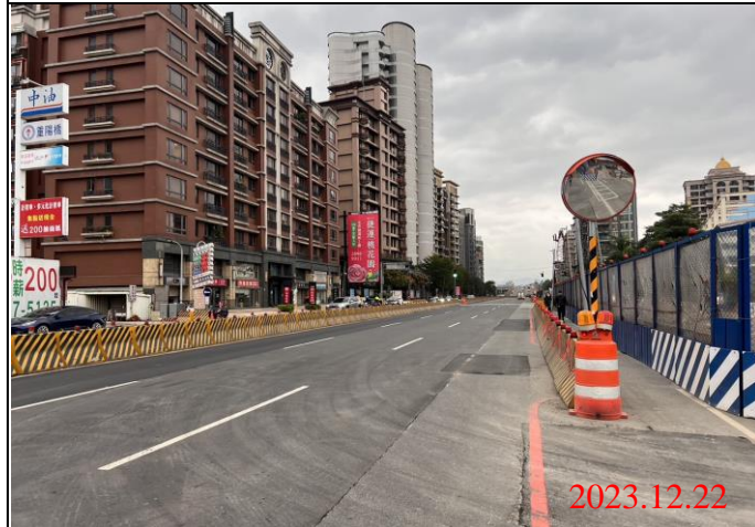
巡查日期地點：112.12.22/ Y23車站 照片說明：路面狀況
