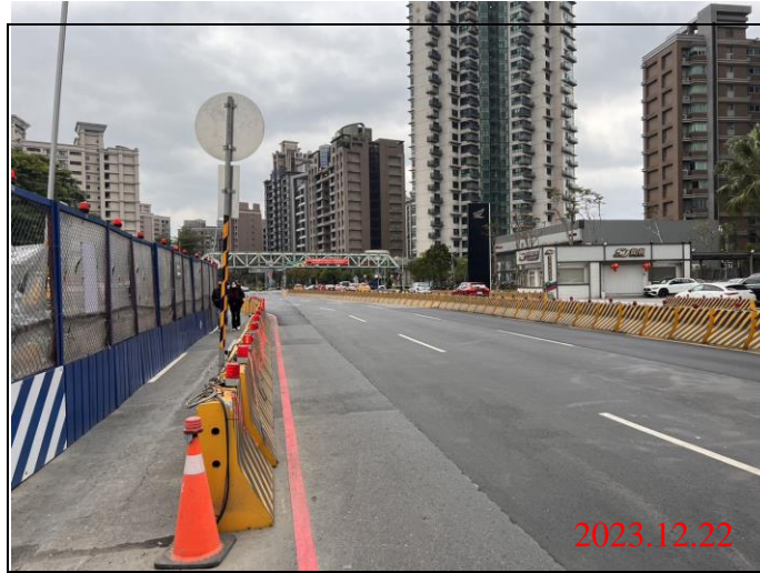
巡查日期地點：112.12.22/ Y23車站 照片說明：路面狀況
