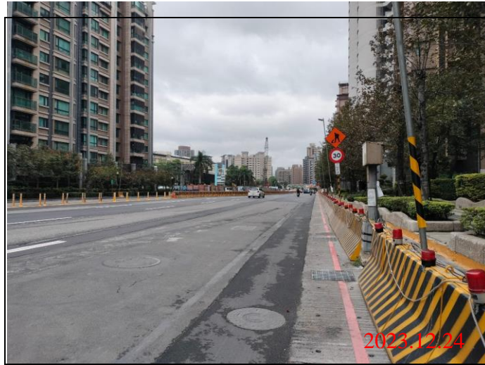
巡查日期地點：112.12.24/ Y23車站 照片說明：路面狀況
