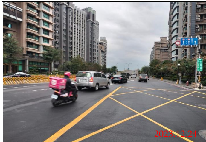
巡查日期地點：112.12.24/ Y23車站 照片說明：路面狀況
