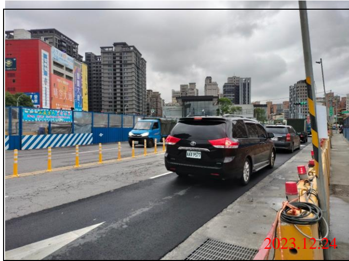
巡查日期地點：112.12.24/ Y22車站 照片說明：路面狀況
