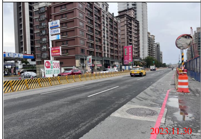
巡查日期地點：112.11.30/ Y23車站 照片說明：路面狀況
