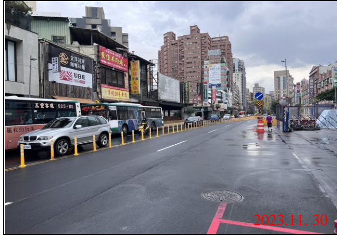
巡查日期地點：112.11.30/ Y21車站 照片說明：路面狀況
