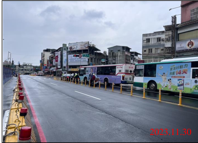
巡查日期地點：112.11.30/ Y21車站 照片說明：路面狀況
