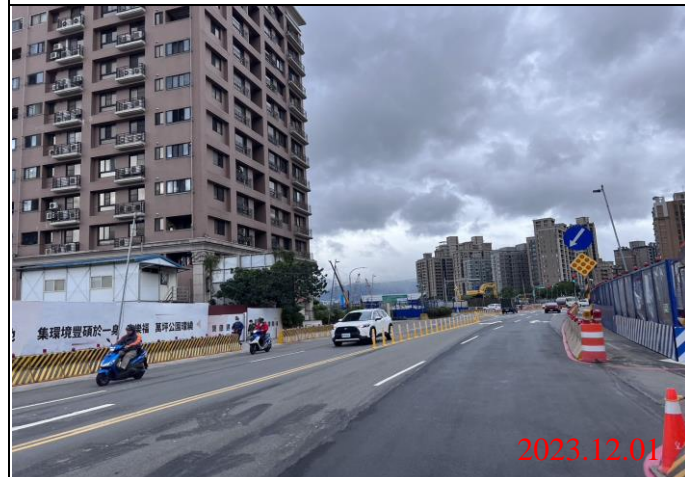
巡查日期地點：112.12.01/ Y22車站 照片說明：路面狀況
