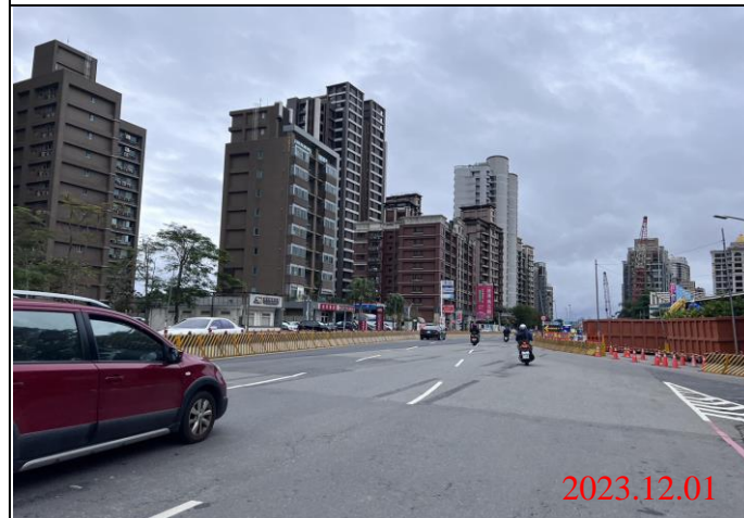
巡查日期地點：112.12.01/ Y23車站 照片說明：路面狀況
