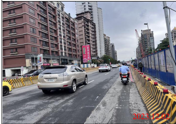
巡查日期地點：112.12.02/ Y23車站 照片說明：路面狀況
