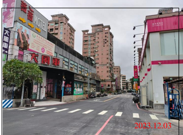
巡查日期地點：112.12.03/ Y21車站 照片說明：路面狀況
