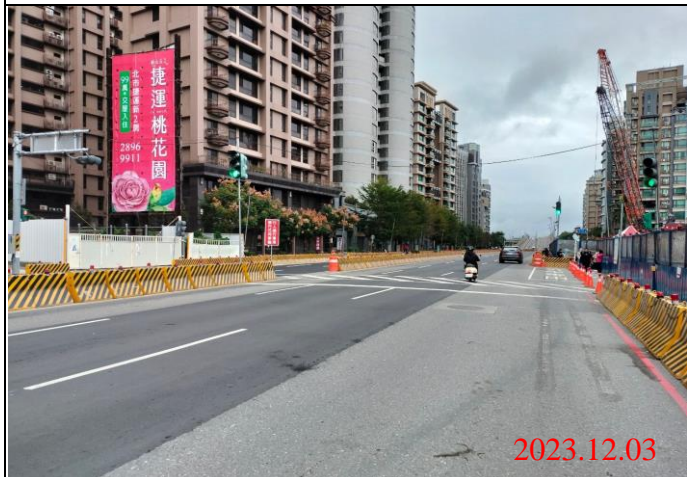
巡查日期地點：112.12.03/ Y23車站 照片說明：路面狀況
