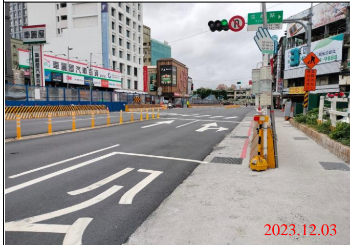
巡查日期地點：112.12.03/ Y21車站 照片說明：路面狀況
