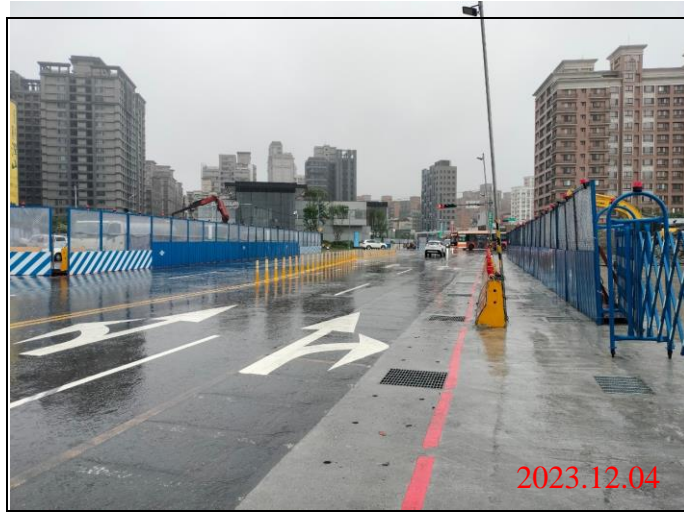
巡查日期地點：112.12.04/ Y22車站 照片說明：路面狀況
