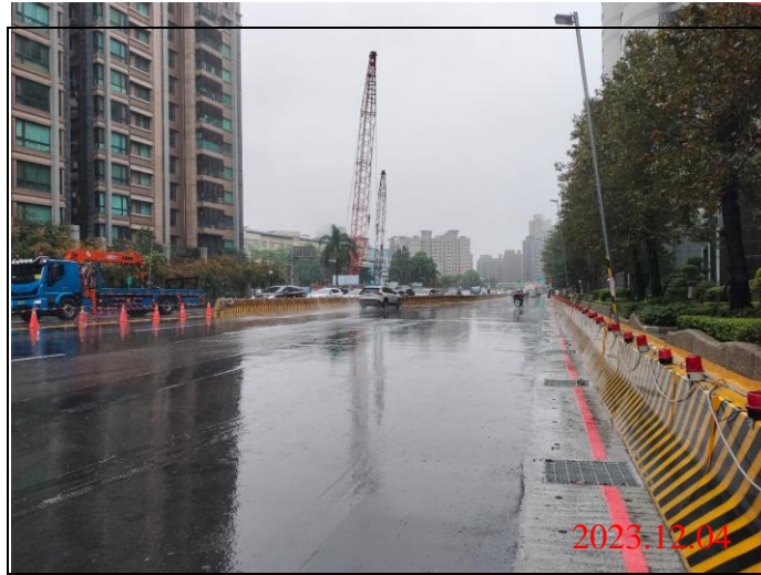
巡查日期地點：112.12.04/ Y23車站 照片說明：路面狀況
