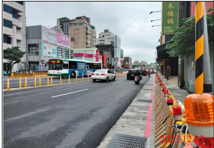
巡查日期地點：112.12.05/ Y21車站 照片說明：路面狀況
