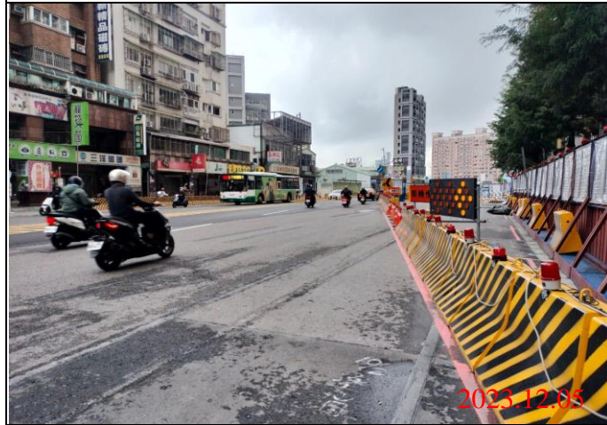
巡查日期地點：112.12.05/ Y22車站 照片說明：路面狀況
