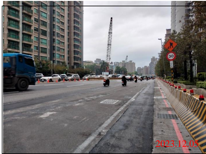
巡查日期地點：112.12.05/ Y23車站 照片說明：路面狀況
