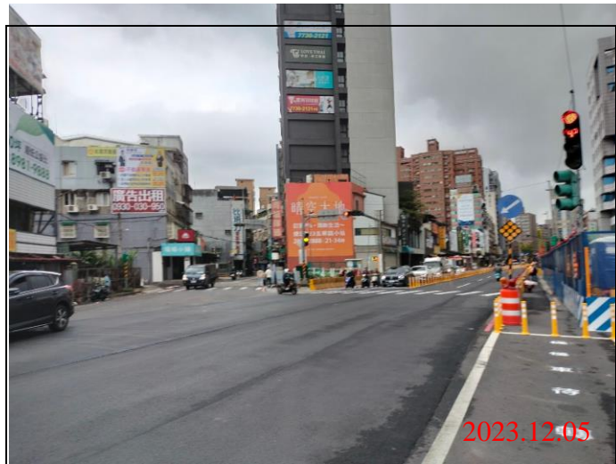
巡查日期地點：112.12.05/ Y21車站 照片說明：路面狀況
