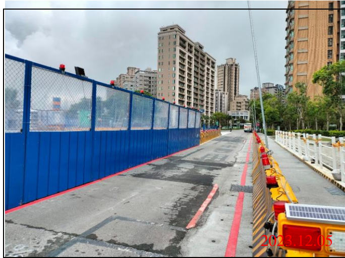
巡查日期地點：112.12.05/ Y22車站 照片說明：路面狀況
