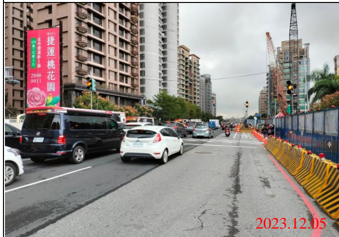
巡查日期地點：112.12.05/ Y23車站 照片說明：路面狀況
