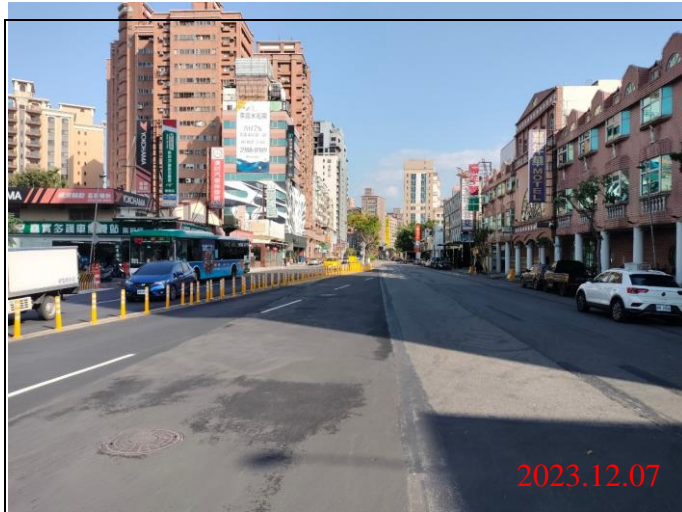
巡查日期地點：112.12.07/ Y21車站 照片說明：路面狀況
