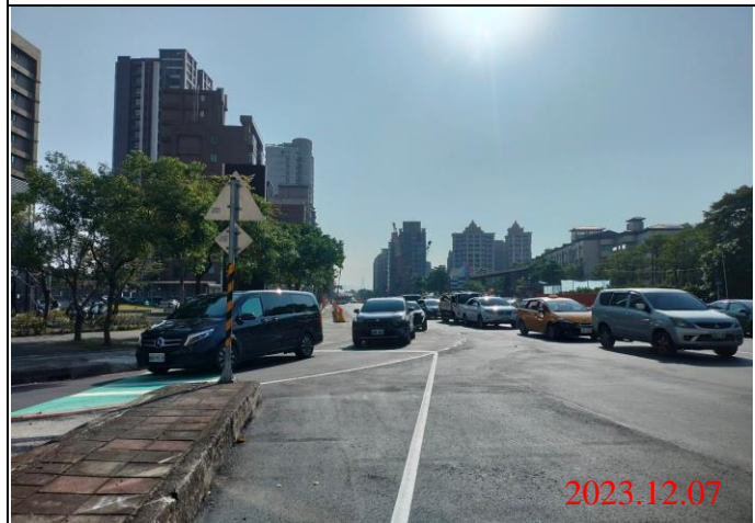
巡查日期地點：112.12.07/ Y23車站 照片說明：路面狀況
