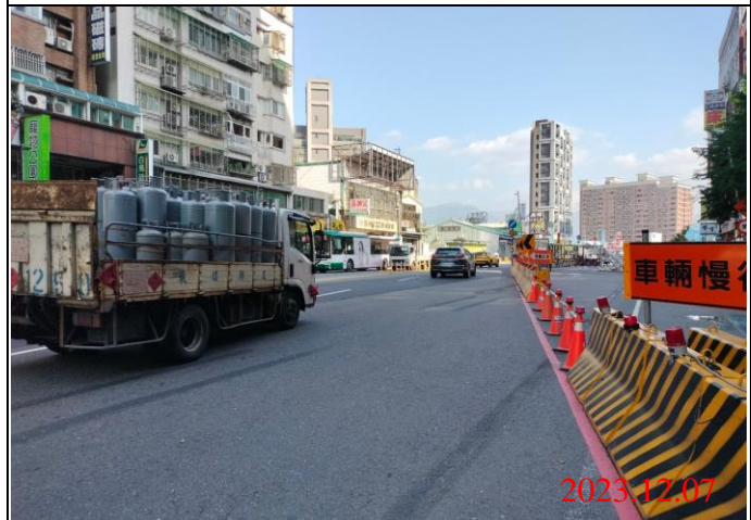
巡查日期地點：112.12.07/ Y22車站 照片說明：路面狀況
