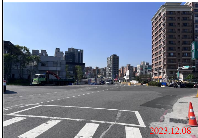
巡查日期地點：112.12.08/ Y22車站 照片說明：路面狀況
