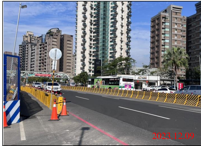
巡查日期地點：112.12.09/ Y23車站 照片說明：路面狀況
