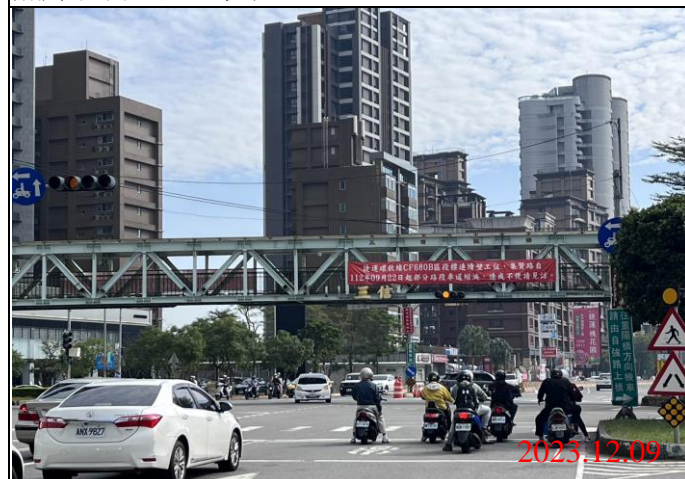
巡查日期地點：112.12.09/ Y23車站 照片說明：路面狀況
