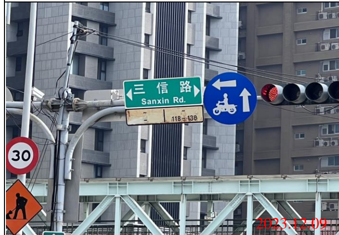
巡查日期地點：112.12.09/ Y23車站 照片說明：牌面設置狀況
