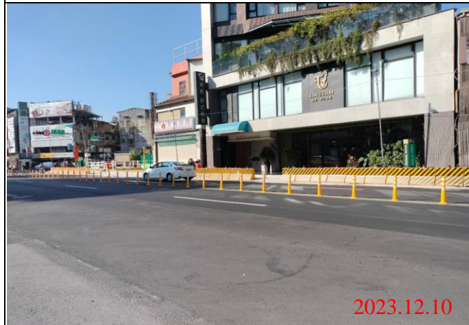
巡查日期地點：112.12.10/ Y21車站 照片說明：路面狀況
