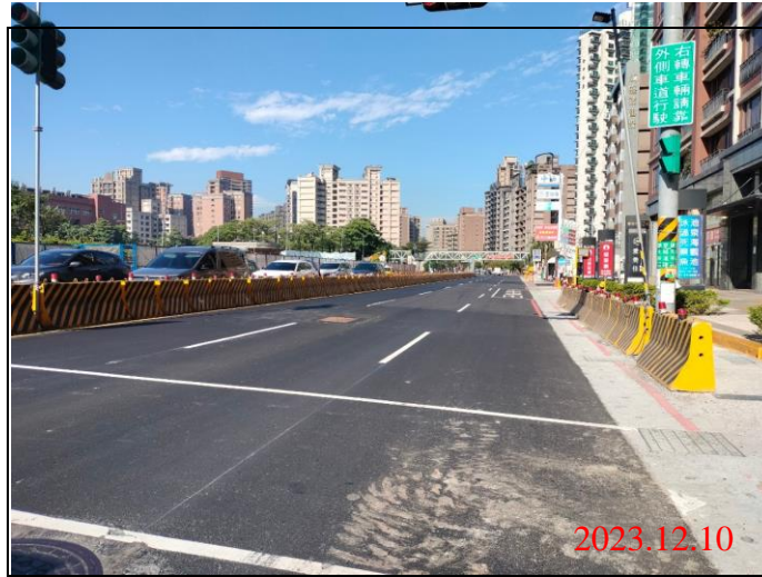
巡查日期地點：112.12.10/ Y23車站 照片說明：路面狀況
