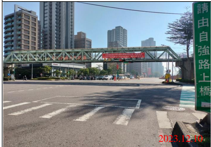
巡查日期地點：112.12.10/ Y23車站 照片說明：路面狀況
