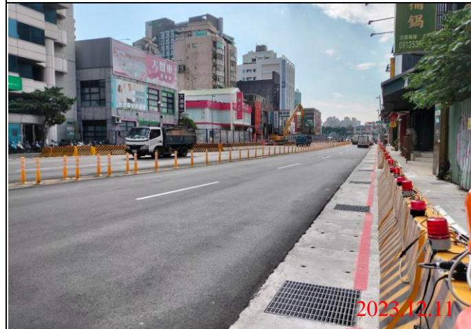
巡查日期地點：112.12.11/ Y21車站 照片說明：路面狀況
