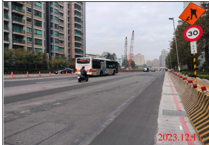
巡查日期地點：112.12.11/ Y23車站 照片說明：路面狀況
