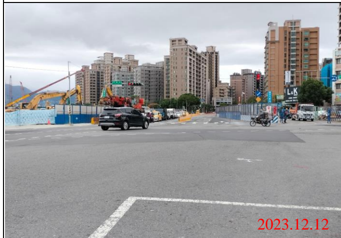
巡查日期地點：112.12.12/ Y22車站 照片說明：路面狀況
