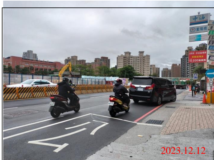
巡查日期地點：112.12.12/ Y23車站 照片說明：路面狀況
