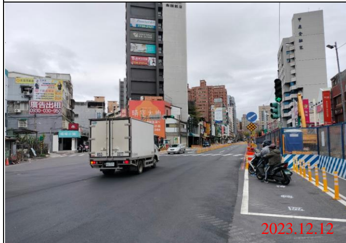
巡查日期地點：112.12.12/ Y21車站 照片說明：路面狀況
