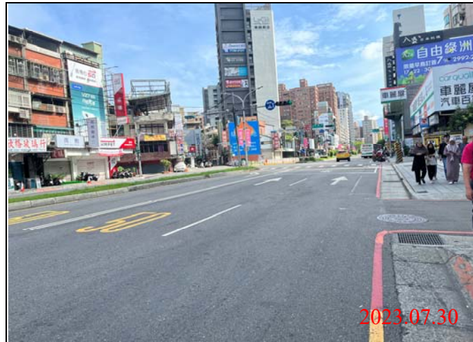
巡查日期地點：112.07.30/ Y21車站 照片說明：路面狀況
