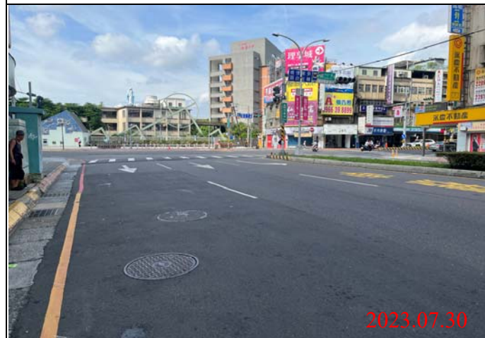
巡查日期地點：112.07.30/ Y21車站 照片說明：路面狀況
