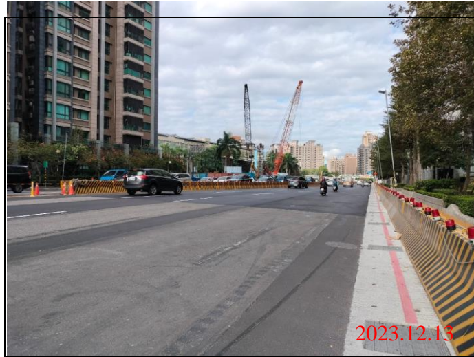
巡查日期地點：112.12.13/ Y23車站 照片說明：路面狀況
