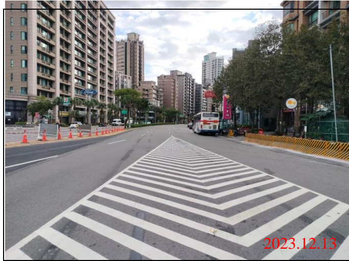
巡查日期地點：112.12.13/ Y22車站 照片說明：路面狀況
