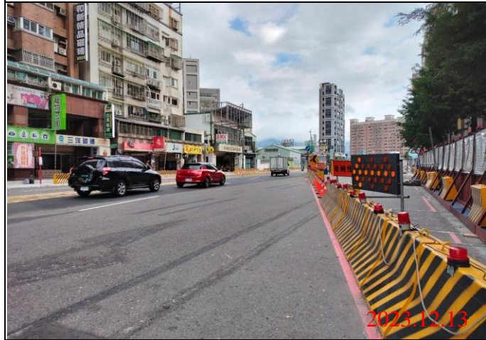
巡查日期地點：112.12.13/ Y22車站 照片說明：路面狀況
