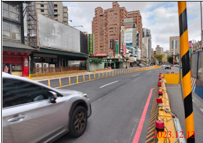
巡查日期地點：112.12.13/ Y21車站 照片說明：路面狀況
