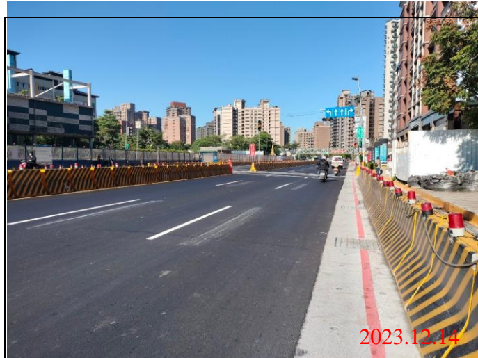
巡查日期地點：112.12.14/ Y23車站 照片說明：路面狀況
