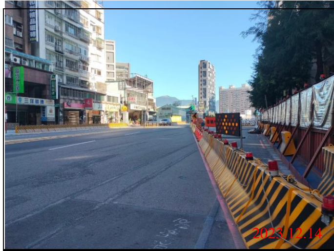
巡查日期地點：112.12.14/ Y22車站 照片說明：路面狀況
