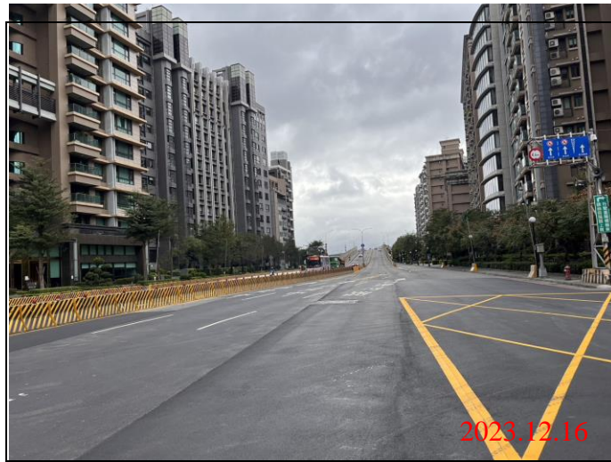
巡查日期地點：112.12.16/ Y23車站 照片說明：路面狀況
