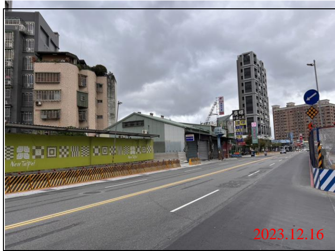
巡查日期地點：112.12.16/ Y22車站 照片說明：路面狀況
