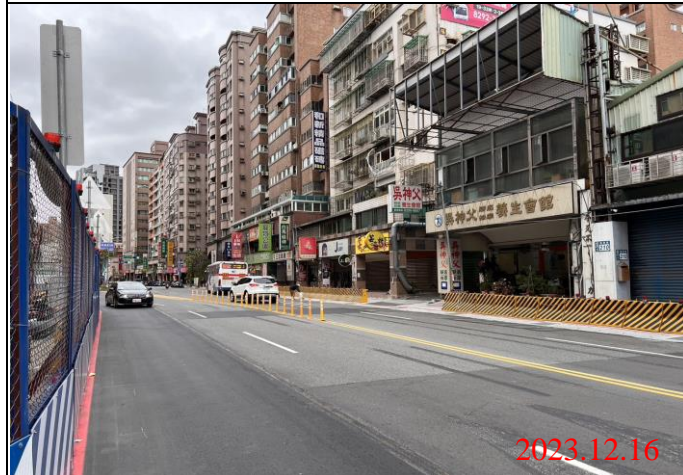
巡查日期地點：112.12.16/ Y22車站 照片說明：路面狀況
