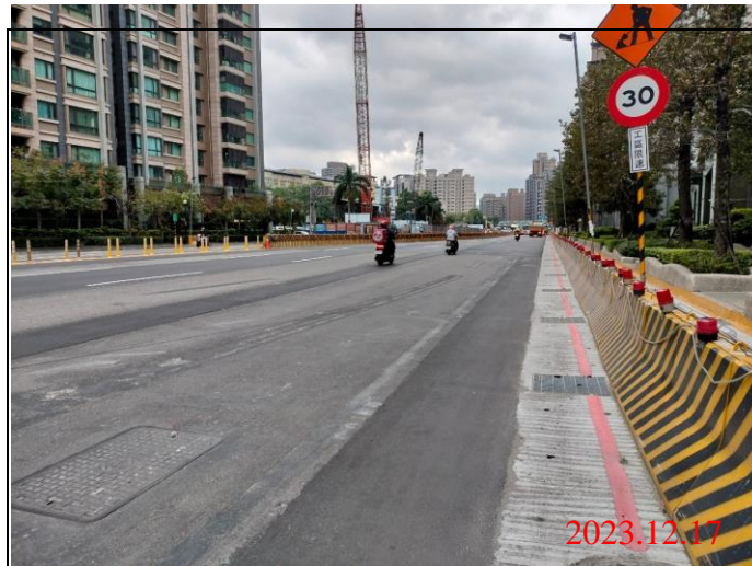
巡查日期地點：112.12.17/ Y23車站 照片說明：路面狀況
