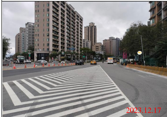
巡查日期地點：112.12.17/ Y22車站 照片說明：路面狀況
