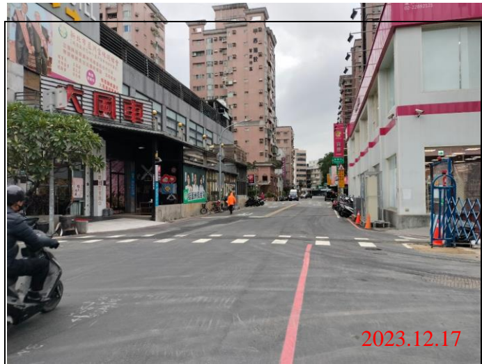
巡查日期地點：112.12.17/ Y21車站 照片說明：路面狀況
