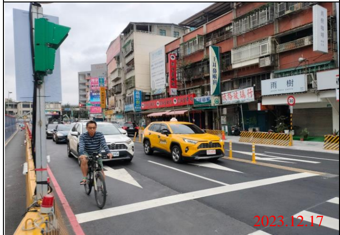
巡查日期地點：112.12.17/ Y21車站 照片說明：路面狀況
