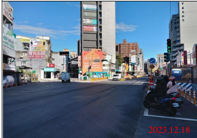
巡查日期地點：112.12.18/ Y21車站 照片說明：路面狀況
