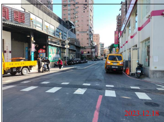
巡查日期地點：112.12.18/ Y21車站 照片說明：路面狀況
