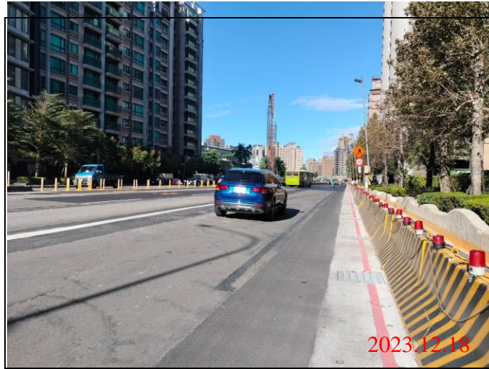
巡查日期地點：112.12.18/ Y23車站 照片說明：路面狀況
