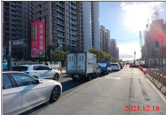
巡查日期地點：112.12.18/ Y23車站 照片說明：路面狀況
