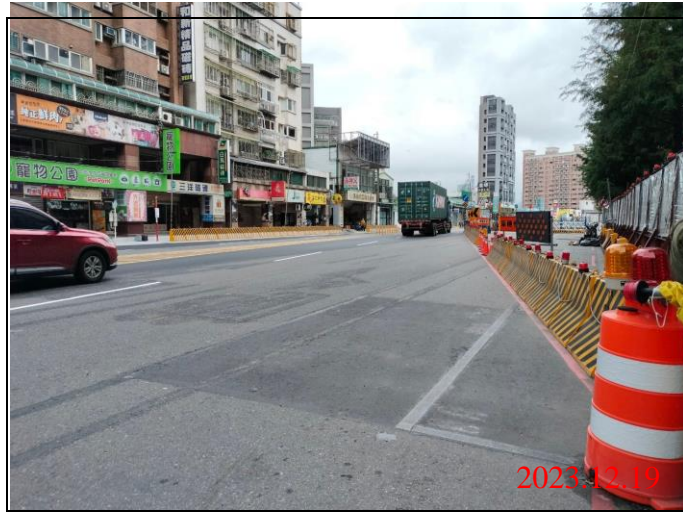
巡查日期地點：112.12.19/ Y22車站 照片說明：路面狀況
