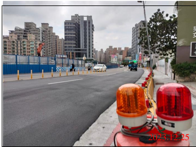
巡查日期地點：112.12.25/ Y22車站 照片說明：路面狀況
