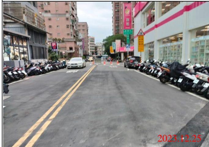
巡查日期地點：112.12.25/ Y21車站 照片說明：路面狀況
