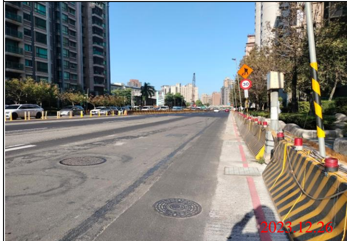
巡查日期地點：112.12.26/ Y23車站 照片說明：路面狀況
