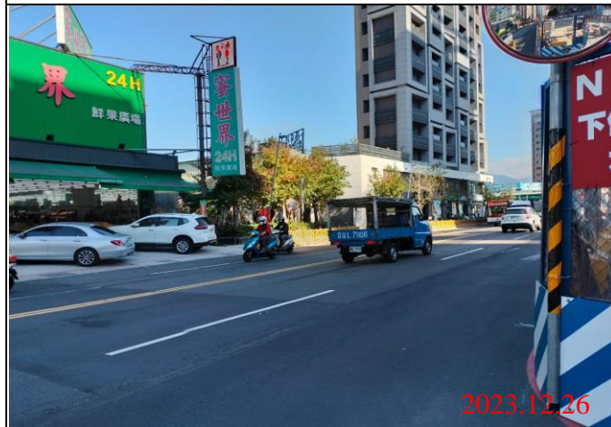
巡查日期地點：112.12.26/ Y22車站 照片說明：路面狀況
