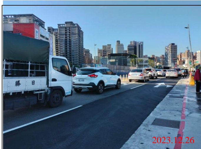
巡查日期地點：112.12.26/ Y22車站 照片說明：路面狀況
