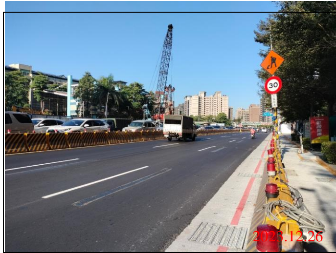
巡查日期地點：112.12.26/ Y23車站 照片說明：路面狀況
