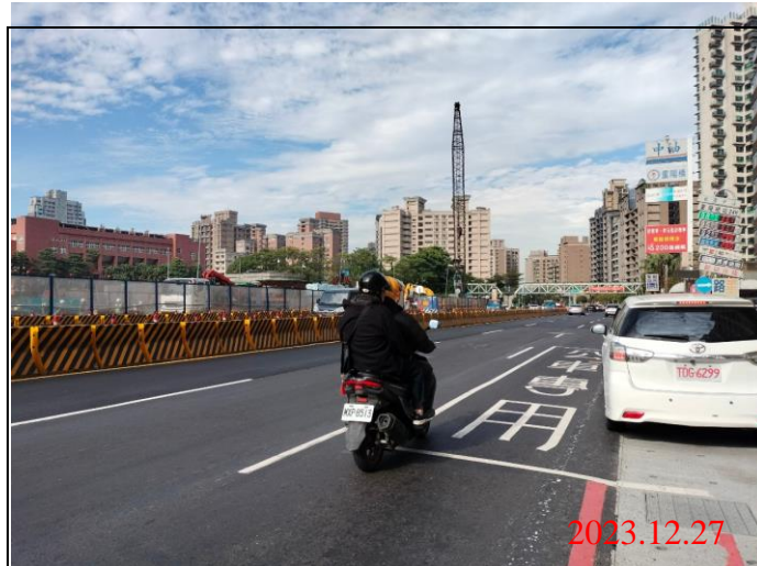
巡查日期地點：112.12.27/ Y23車站 照片說明：路面狀況
