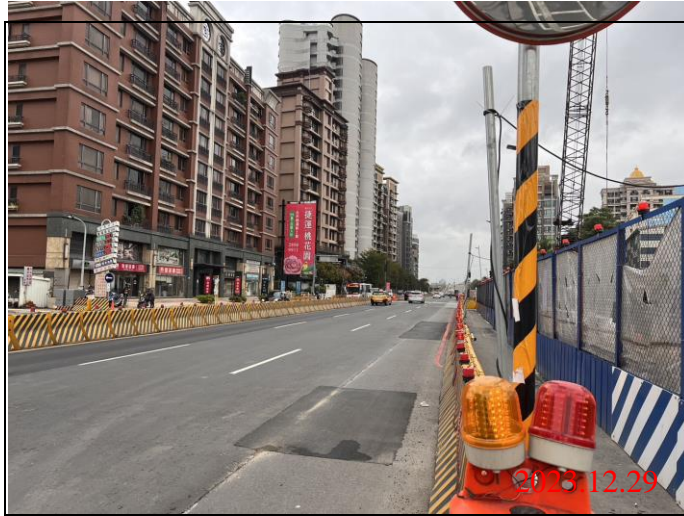
巡查日期地點：112.12.29/ Y23車站 照片說明：路面狀況
