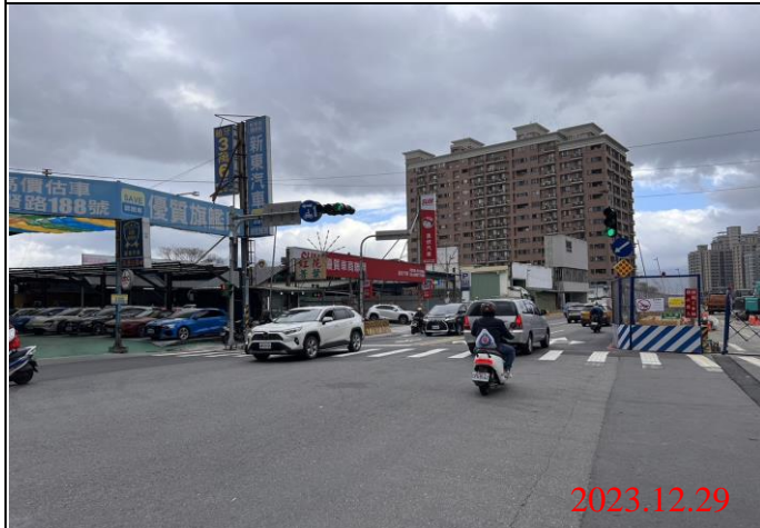
巡查日期地點：112.12.29/ Y22車站 照片說明：路面狀況
