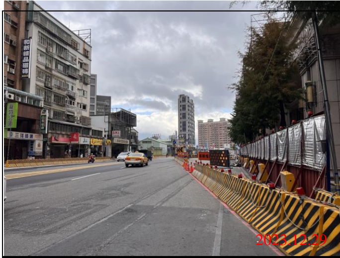
巡查日期地點：112.12.29/ Y22車站 照片說明：路面狀況
