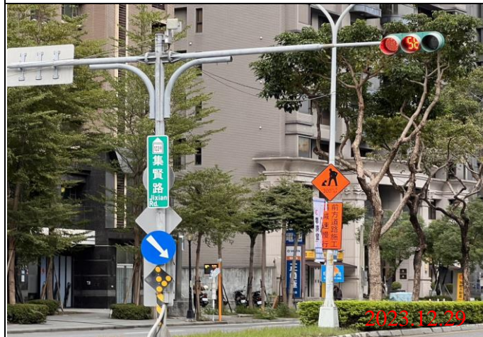
巡查日期地點：112.12.29/ Y22車站 照片說明：牌面設置狀況
