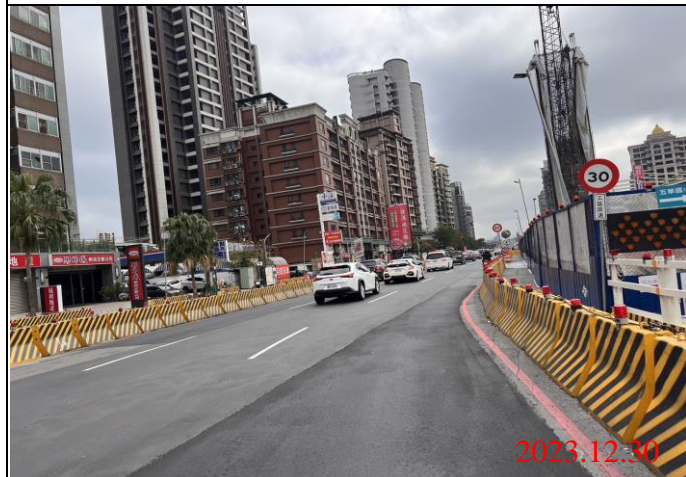
巡查日期地點：112.12.30/ Y23車站 照片說明：路面狀況
