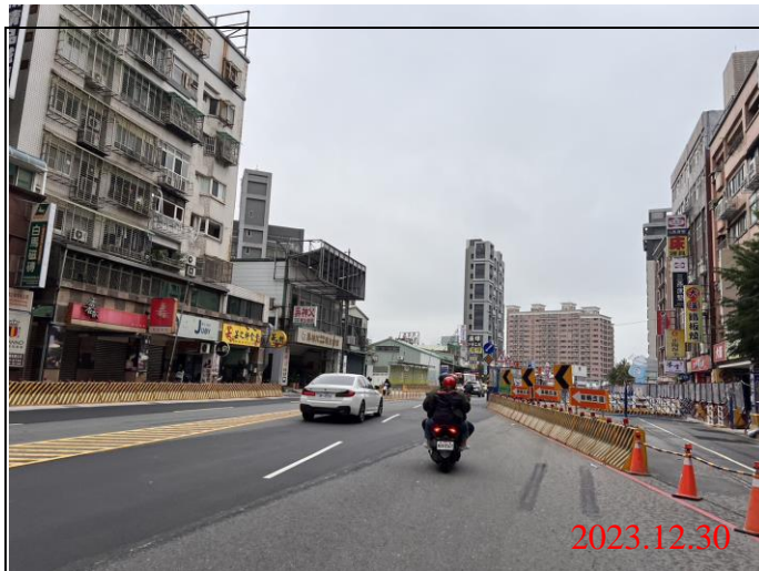
巡查日期地點：112.12.30/ Y22車站 照片說明：路面狀況
