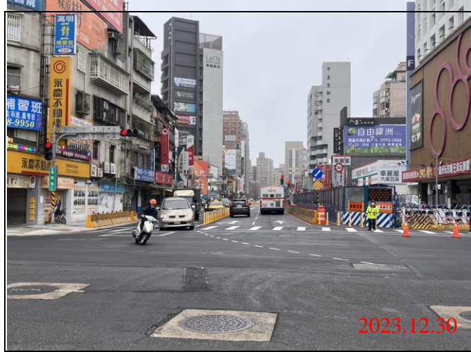
巡查日期地點：112.12.30/ Y21車站 照片說明：路面狀況
