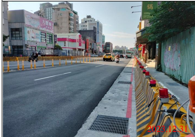
巡查日期地點：112.12.31/ Y21車站 照片說明：路面狀況
