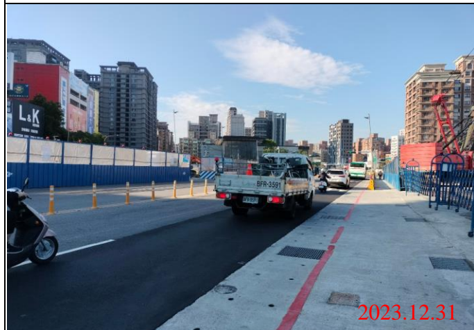
巡查日期地點：112.12.31/ Y22車站 照片說明：路面狀況
