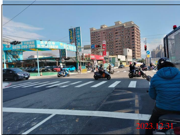
巡查日期地點：112.12.31/ Y22車站 照片說明：路面狀況
