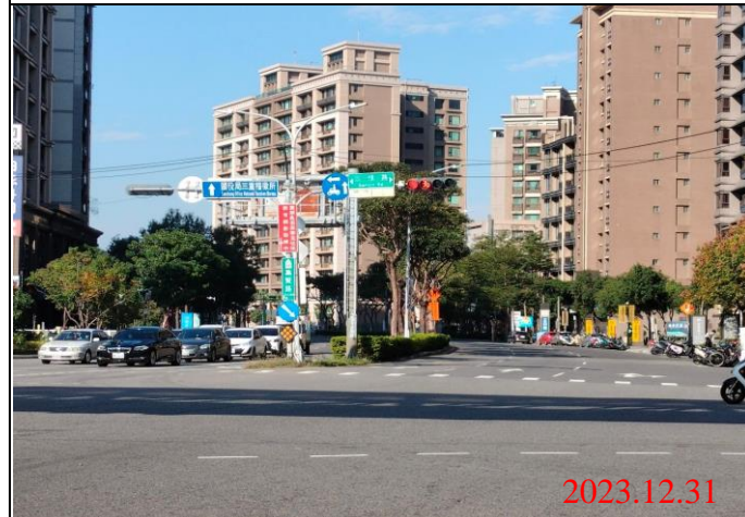
巡查日期地點：112.12.31/ Y23車站 照片說明：牌面設置狀況
