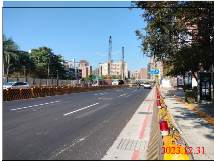
巡查日期地點：112.12.31/ Y23車站 照片說明：路面狀況
