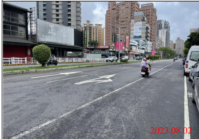
巡查日期地點：112.08.02/ Y21車站 照片說明：路面狀況
