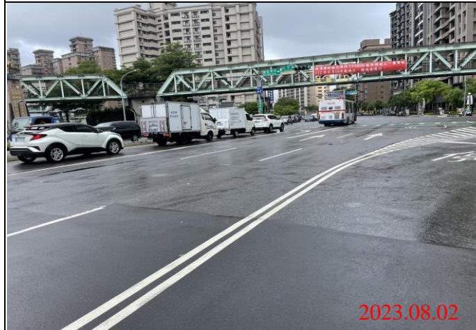
巡查日期地點：112.08.02/ Y23車站 照片說明：路面狀況
