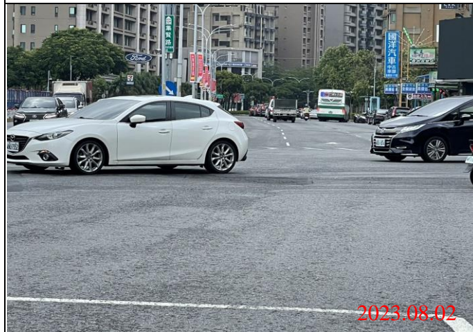
巡查日期地點：112.08.02/ Y22車站 照片說明：路面狀況
