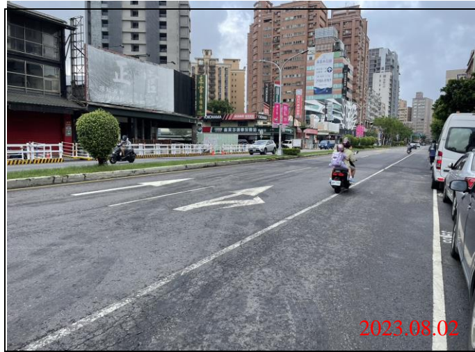
巡查日期地點：112.08.02/ Y22車站 照片說明：路面狀況
