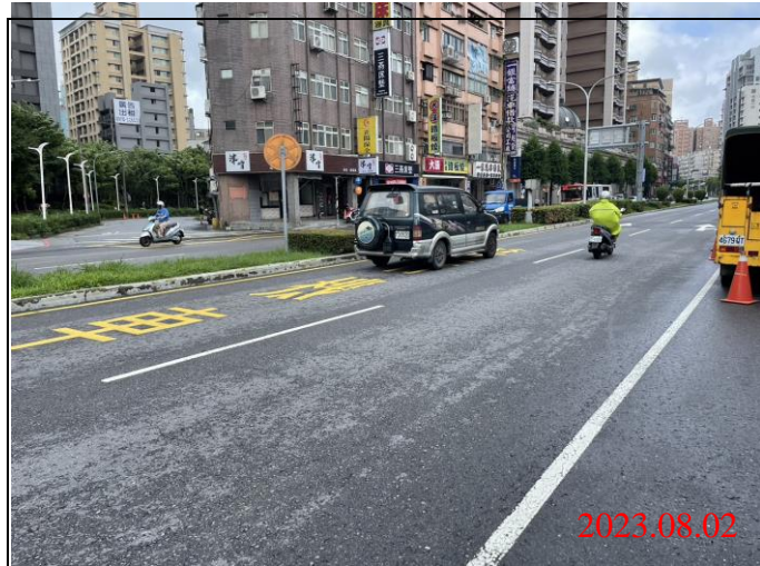
巡查日期地點：112.08.02/ Y21車站 照片說明：路面狀況
