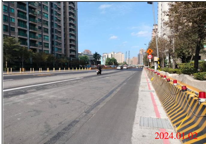
巡查日期地點：113.01.02/ Y23車站 照片說明：路面狀況
