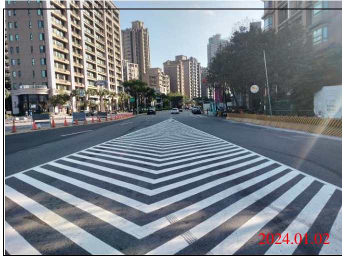
巡查日期地點：113.01.02/ Y22車站 照片說明：路面狀況
