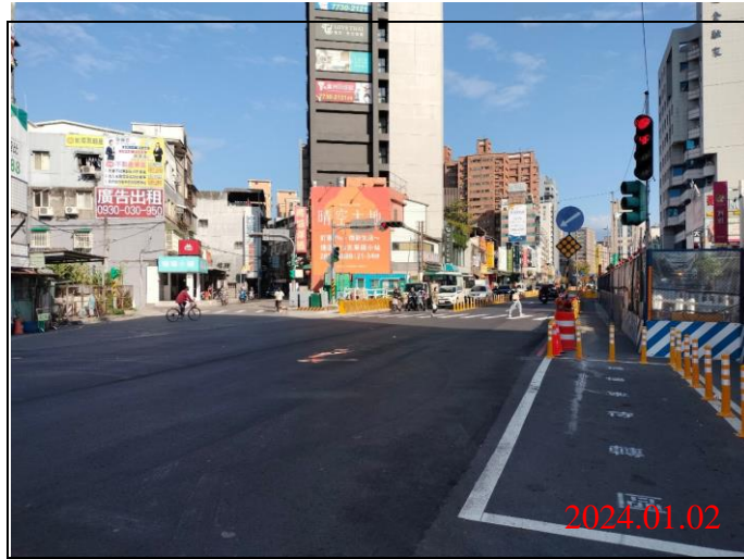
巡查日期地點：113.01.02/ Y21車站 照片說明：路面狀況
