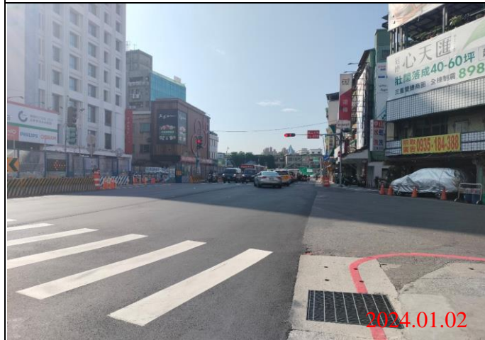
巡查日期地點：113.01.02/ Y21車站 照片說明：路面狀況
