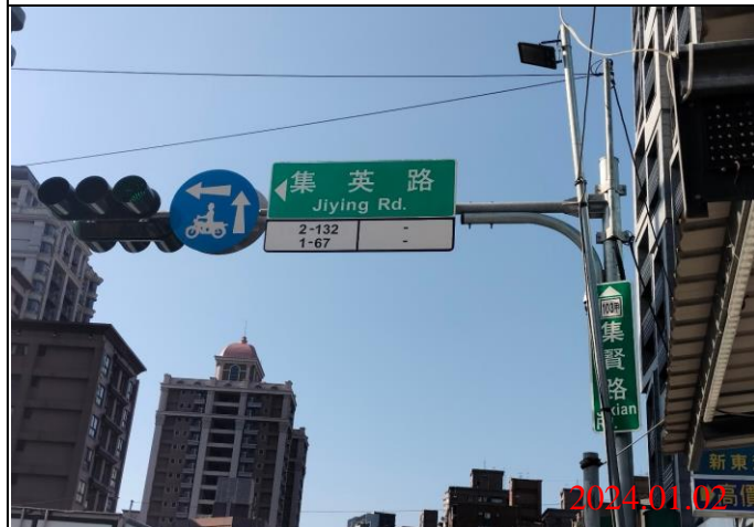
巡查日期地點：113.01.02/ Y22車站 照片說明：牌面設置狀況
