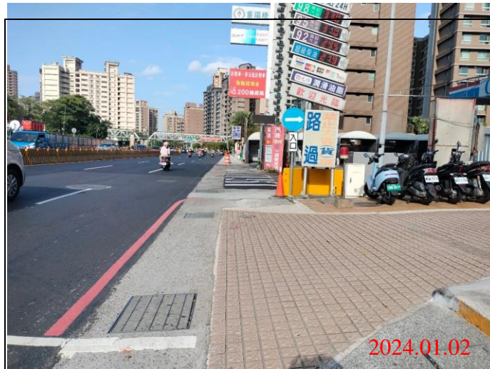
巡查日期地點：113.01.02/ Y23車站 照片說明：路面狀況
