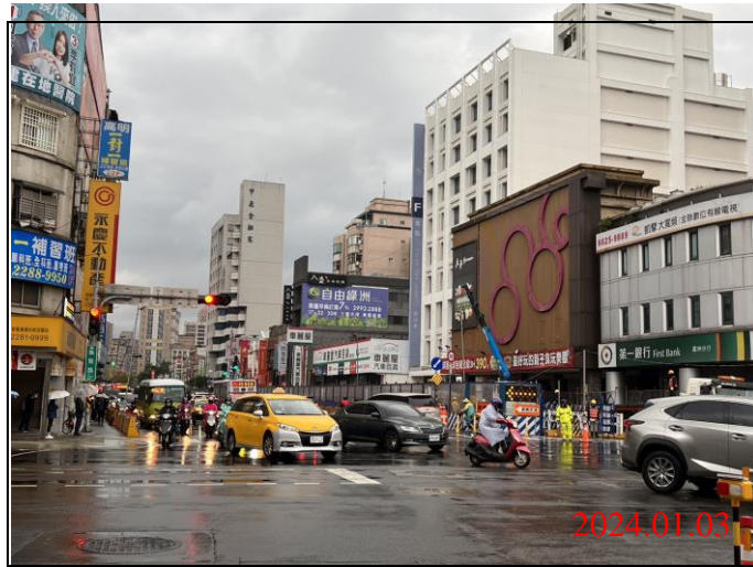
巡查日期地點：113.01.03/ Y21車站 照片說明：路面狀況
