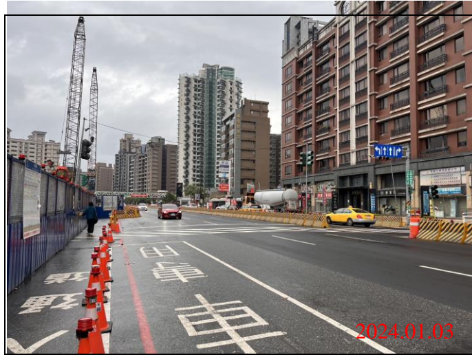
巡查日期地點：113.01.03/ Y23車站 照片說明：路面狀況
