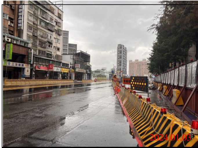
巡查日期地點：113.01.03/ Y22車站 照片說明：路面狀況
