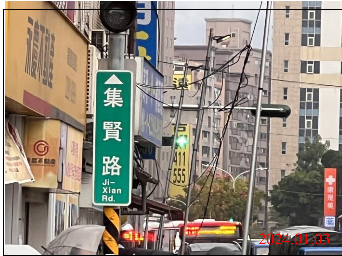
巡查日期地點：113.01.03/ Y21車站 照片說明：牌面設置狀況
