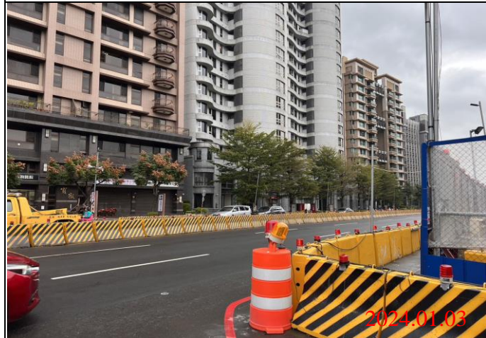
巡查日期地點：113.01.03/ Y23車站 照片說明：路面狀況
