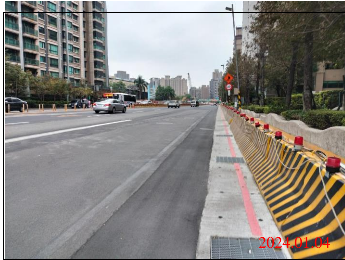
巡查日期地點：113.01.04/ Y23車站 照片說明：路面狀況
