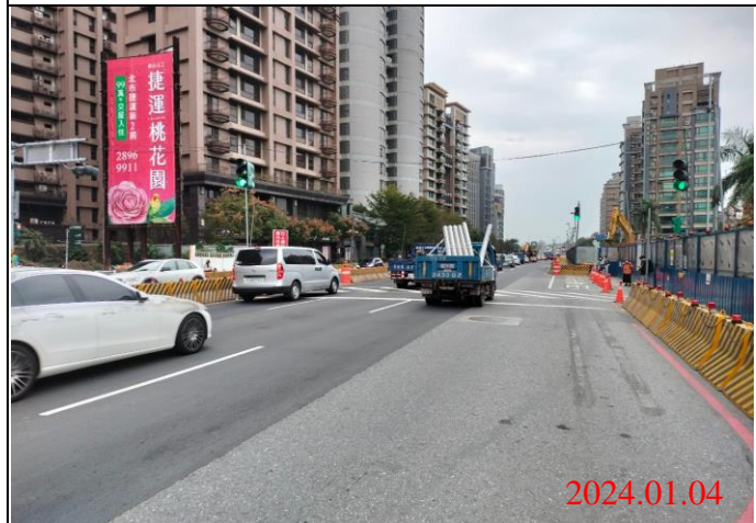
巡查日期地點：113.01.04/ Y23車站 照片說明：路面狀況
