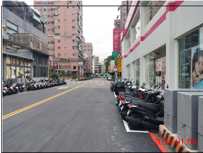
巡查日期地點：113.01.04/ Y21車站 照片說明：路面狀況
