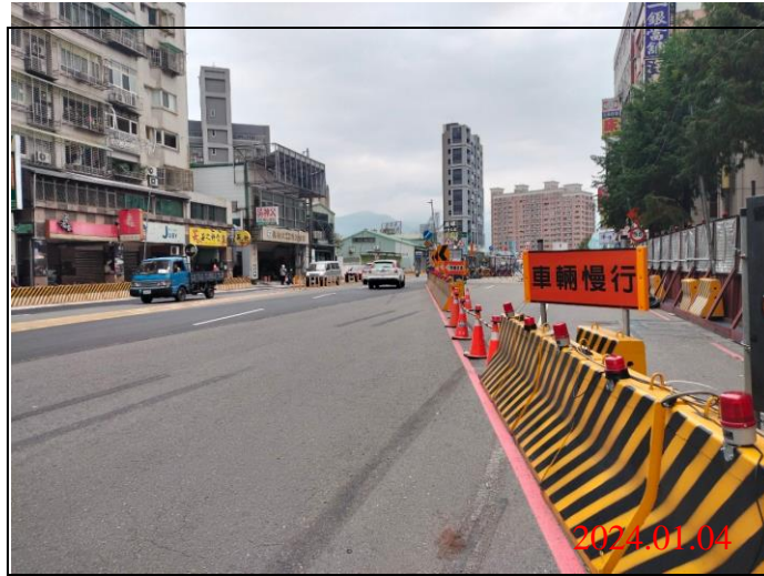
巡查日期地點：113.01.04/ Y22車站 照片說明：路面狀況
