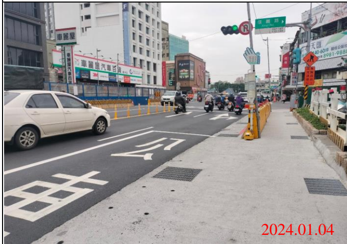
巡查日期地點：113.01.04/ Y21車站 照片說明：路面狀況
